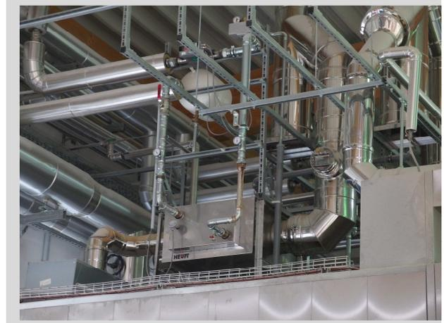
Absaugung und Umleitung des Schwad- und Rauchgases
