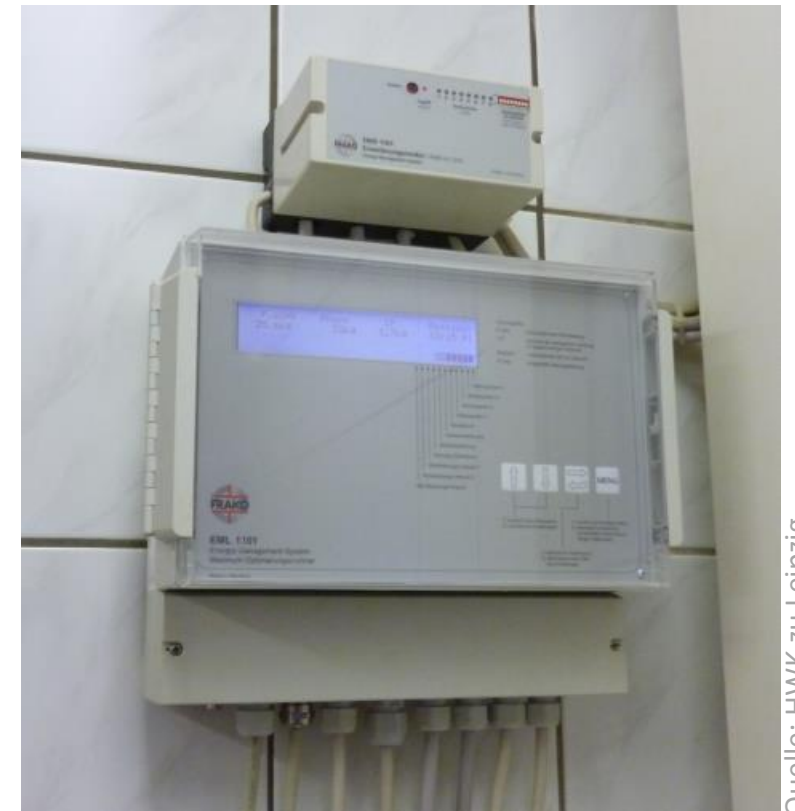
Lastoptimierungsanlage in einer Bäckerei
